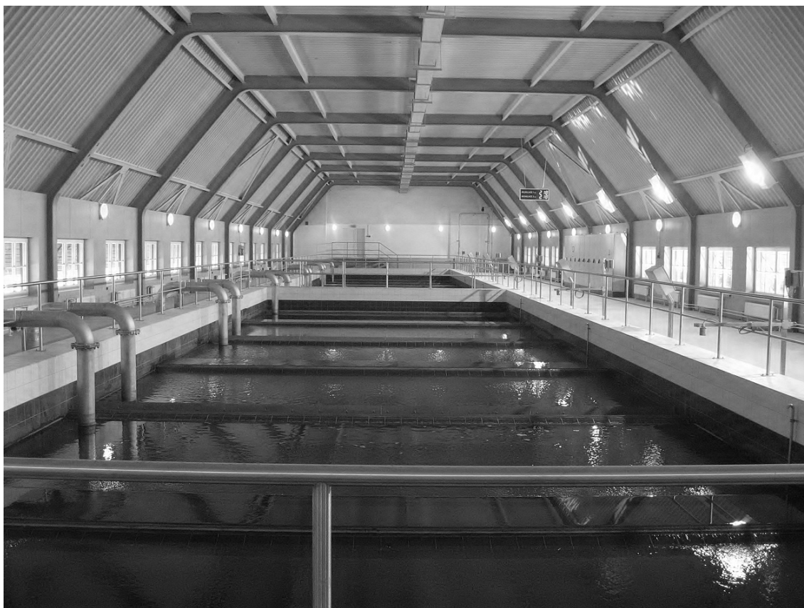
Obrázek 1. Rekonstruovaná hala filtrů
